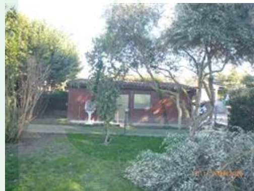
autorimessa in legno su area cortilizia in proprietà (da demolire)
